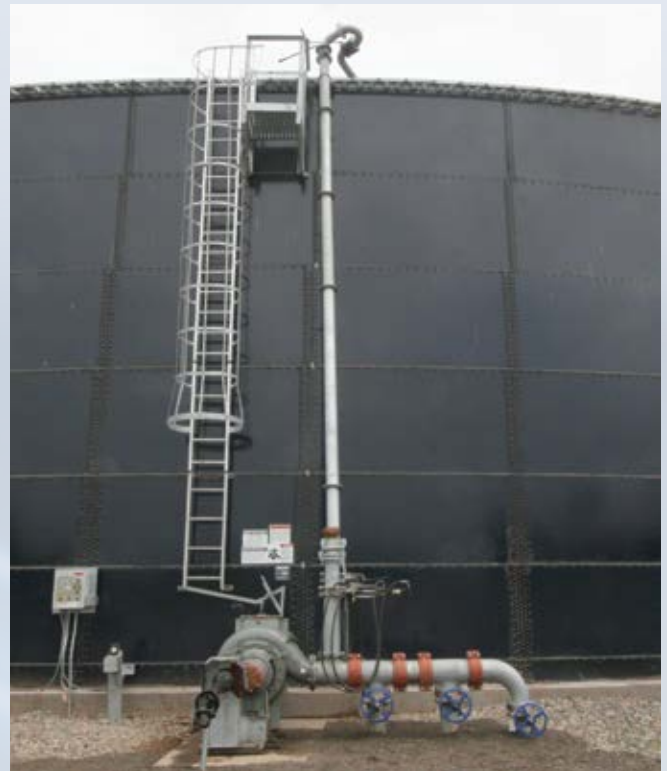
Pompe Slurrystore 2400 assortie d'une buse d'agitation Deluxe dans la partie supérieure
